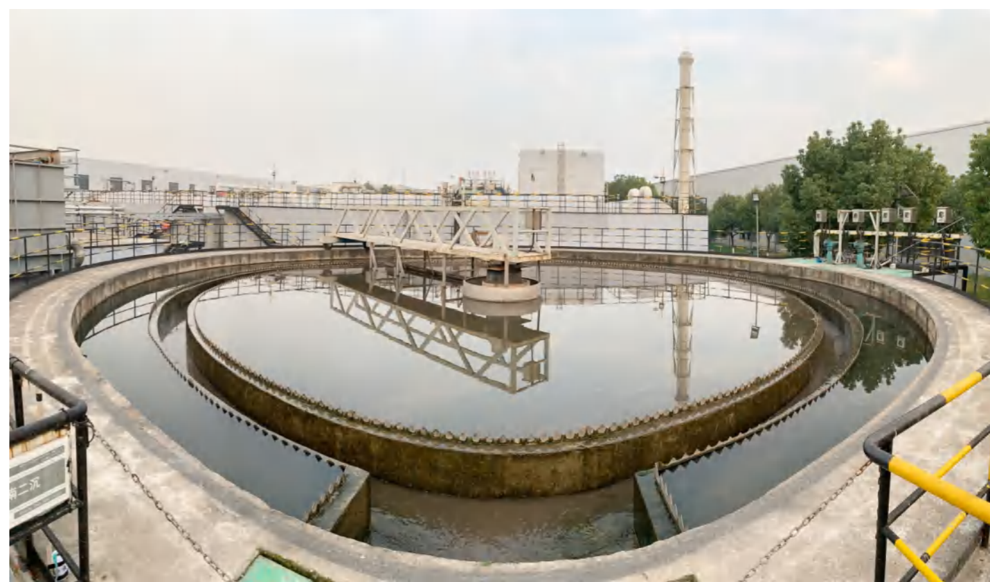
苏州光伏污水站俯瞰图
